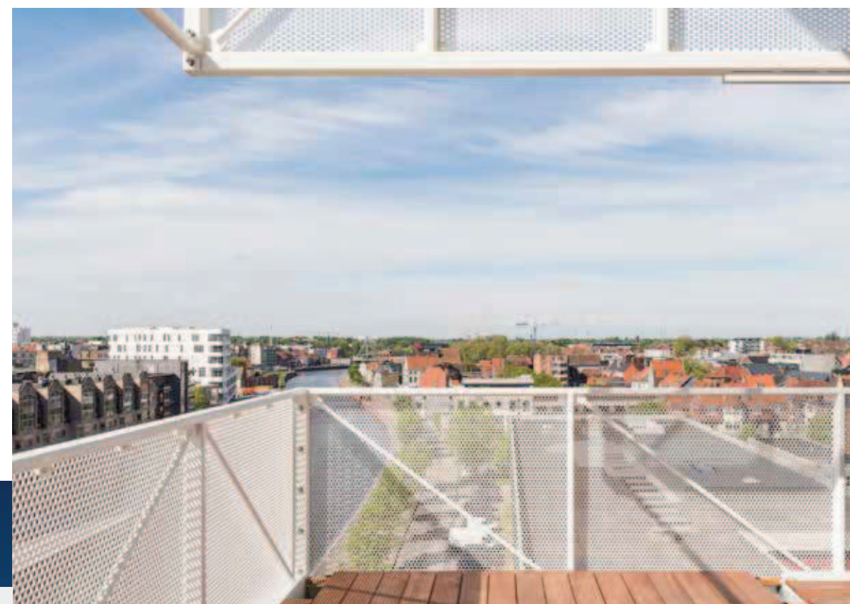
De witte metalen terrassen kregen een borstwering met geperforeerde platen en zijn afgewerkt met een hardhouten vloer.
