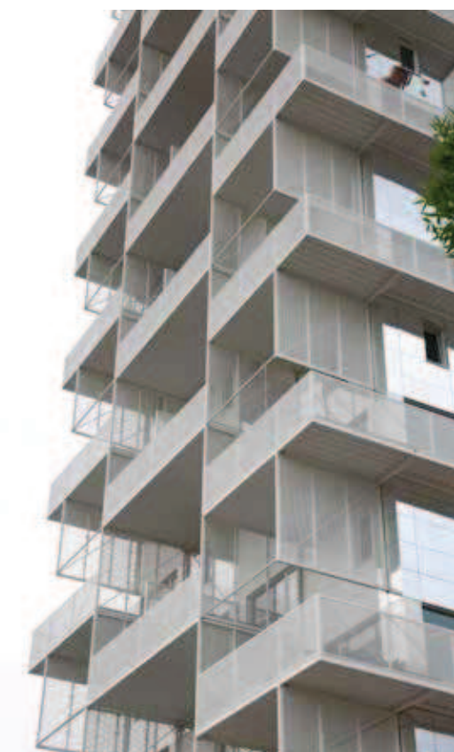
Een unieke troef zijn de ruime dubbelhoge terrassen, die over elke bouwlaag verspringen.
